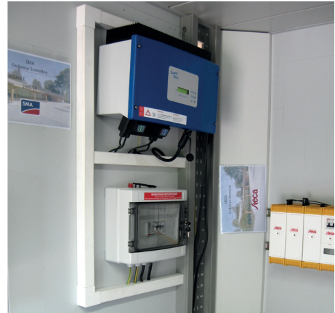
Distribution de câbles, France
