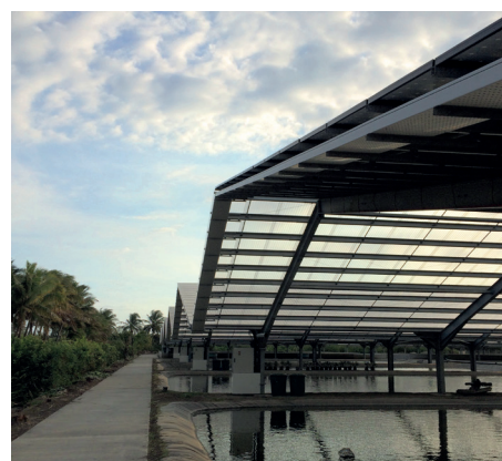
Toit solaire sur serre - Etang Salé, La Réunion - France
